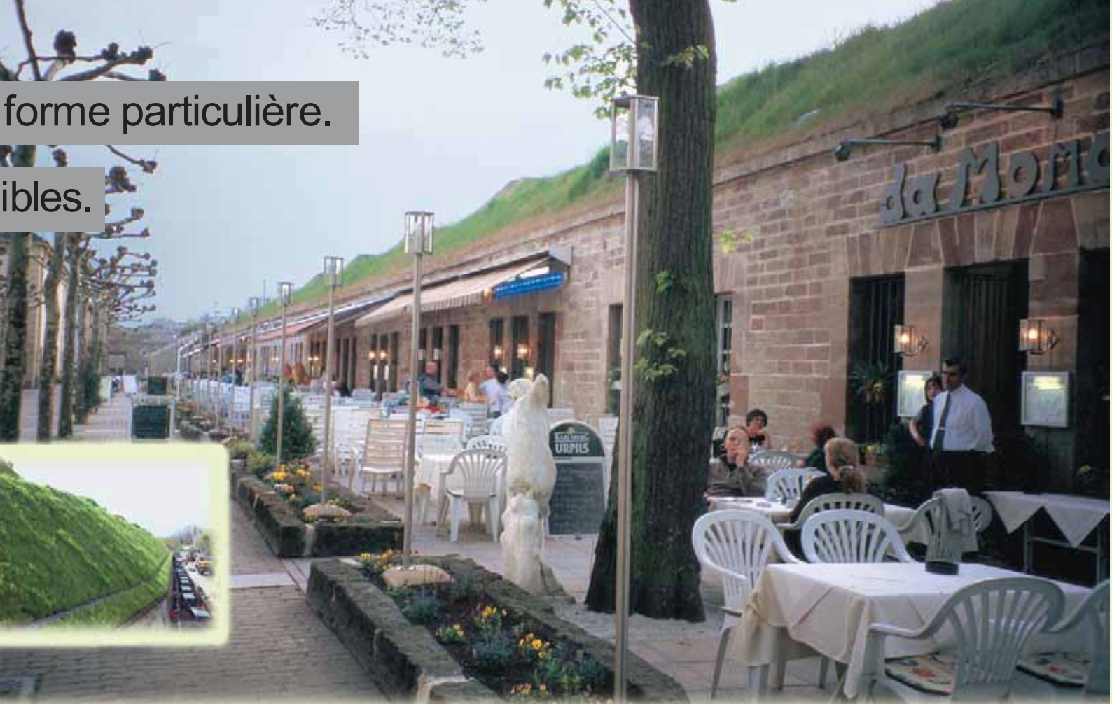
Le « fortin », situé à l'entrée de la zone piétonne, retrouve aujourd'hui son aspect d'origine.
