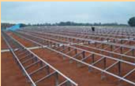
Entsprechend der notwendigen Auflast werden die Solarbasis®-Platten mit Zincoterre® überdeckt.
