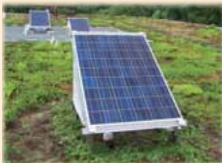
Hierbei wurden zwei Module über „nackten“ Bitumenbahnen einem Modul über einer Dachbegrünung gegenübergestellt. Hauptaugenmerk galt den jeweiligen Tempera-
