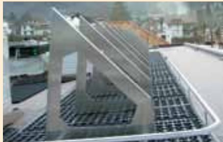
Kopplung der Anlage mit Aluprofilen z.B. bei einem Standort mit Windzone 2 und Zuschlag „Küste“ und ungünstigen baulichen Voraussetzungen.
