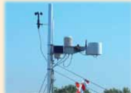
turen an den Unterseiten der Panelflächen. Über das gesamte Jahr hinweg wurden durchschnittliche Tagestemperaturdifferenzen von ca. 8 K gemessen.
