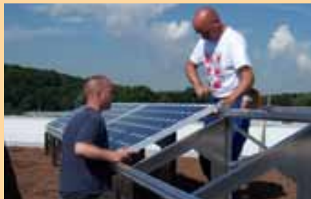
Die Solarpanels werden montiert.
