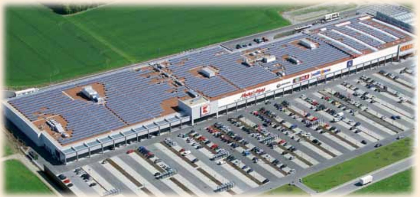
Photovoltaik-Anlage auf dem InCenter in Landsberg/Lech nach der Fertigstellung
